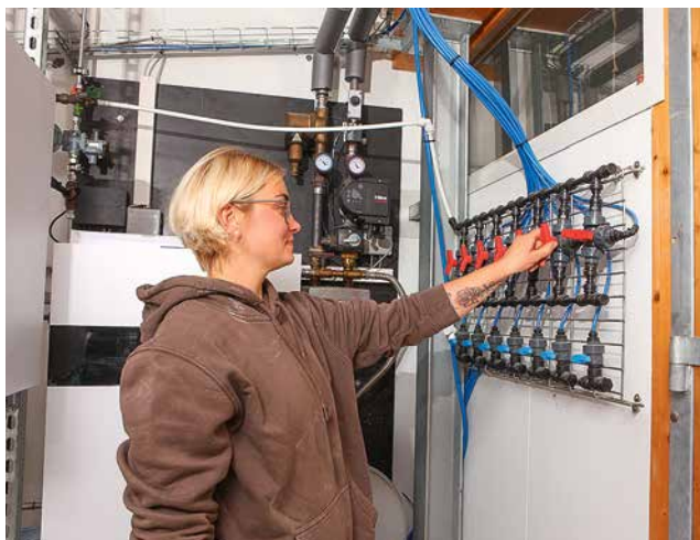
△ Durch die Absperrhähne wechselt Kim Krug von Milch zu Wasser. Hier könnte sie die Milch auch verschiedenen Ferkelgruppen zuteilen.
